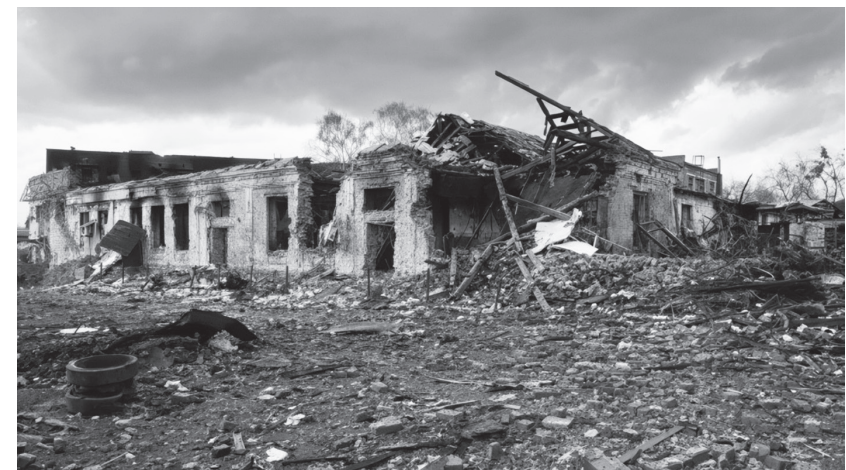
Зруйнований внаслідок російського обстрілу будинок на Сумщині 360
